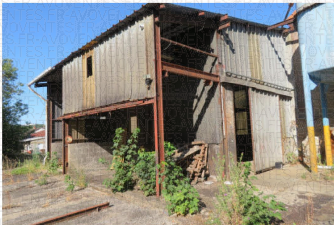
(pignon gauche – appentis)
