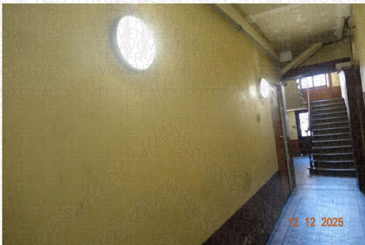
Vue de la porte d'accès au local :
