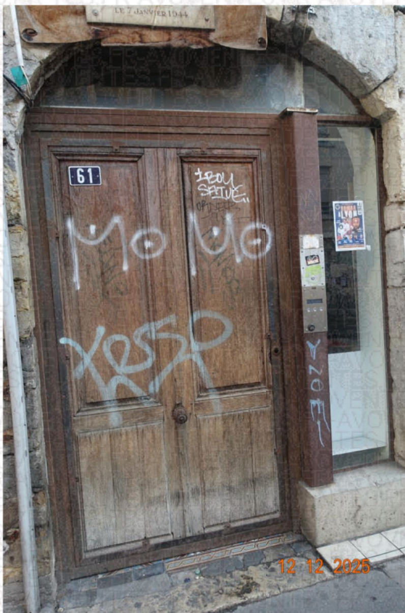
Cette porte cochère est dotée d'une fermeture par « VIGIK ».
