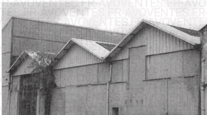
Ceci se poursuit jusqu'en dernière partie où l'on retrouve le verrières sur un pan, les tuiles mécaniques sur l'autre pan.
