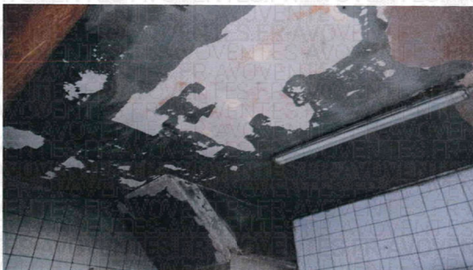
En partie supérieure, plafond plâtre présentant des dégradations importantes.
