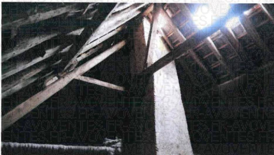
Et sur l'arrière le conduit de cheminée démontée au droit de la pièce à usage de séjour.
