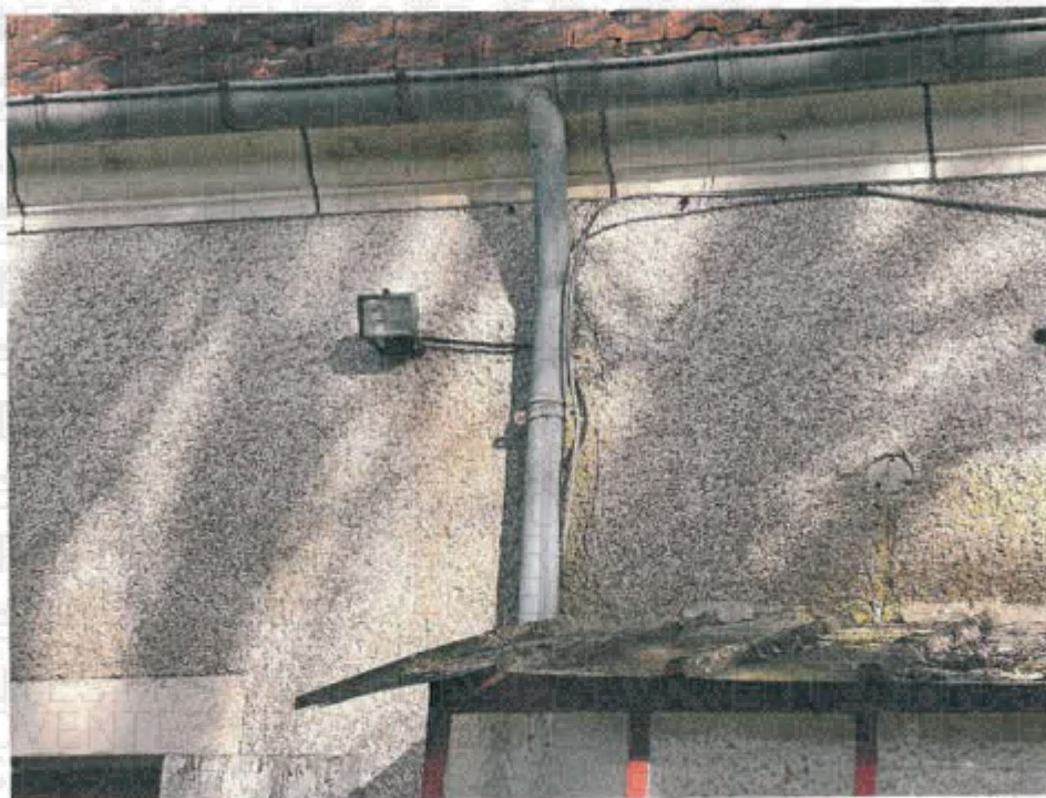
Le revêtement crépi sur pignon droit est partiellement décollé dans l'alignement du conduit de cheminée, auréoles d'humidité, outre végétation grimpante type lierre.
