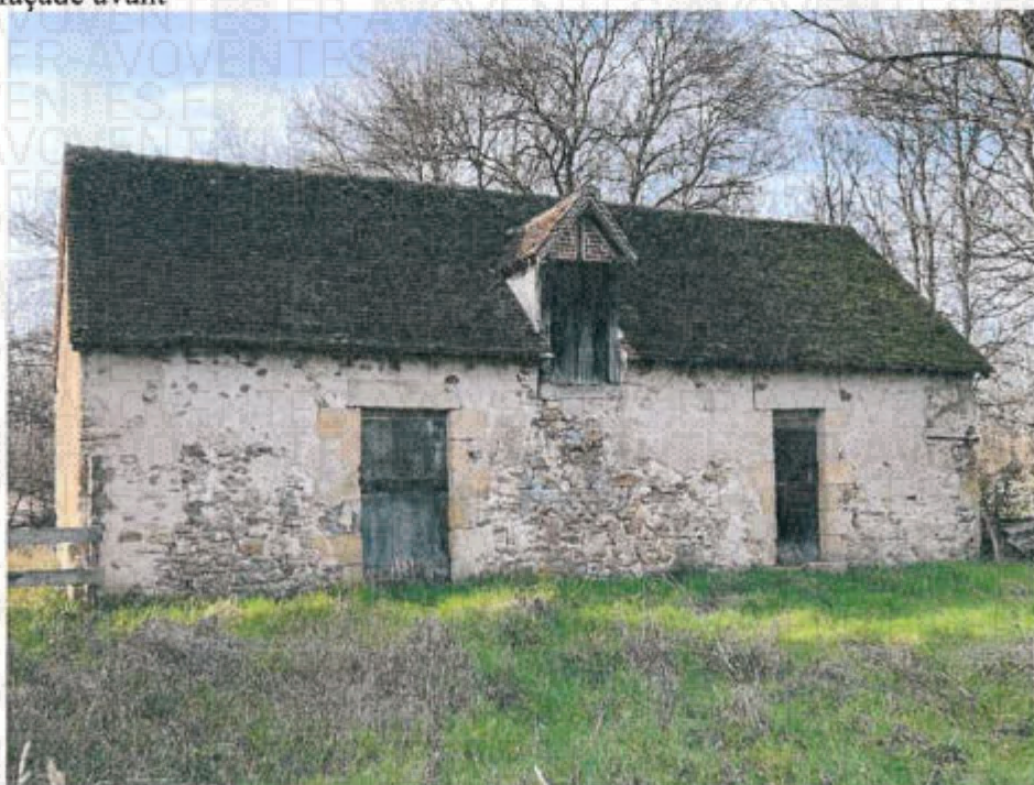
Vue en façade avant
