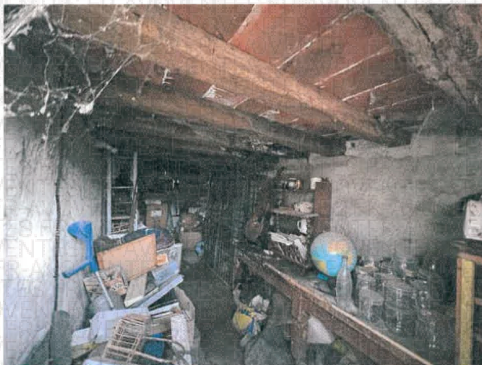
Vue intérieure de l'appentis
