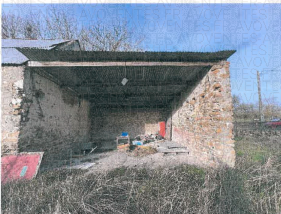
La remise d'une surface de 21.64m 2 hors Loi Carrez dispose d'un grenier avec ouverture sur pignon. Au rez-de-chaussée, accessible par une porte bois ancienne, la remise reçoit un sol pavé murs partiellement visibles avec enduit ancien affectés par l'humidité. Plafond poutres bois avec plancher en briques.
