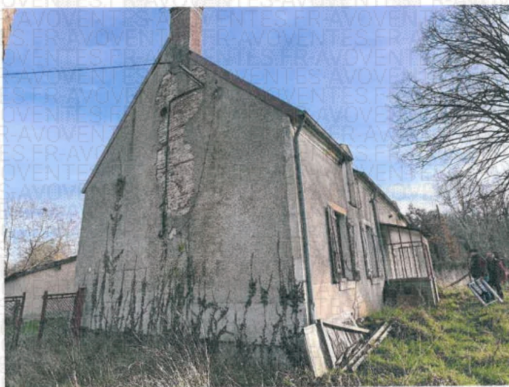
Le revêtement crépi sur pignon droit est partiellement décollé dans l'alignement du conduit de cheminée, auréoles d'humidité, outre végétation grimpante type lierre.
