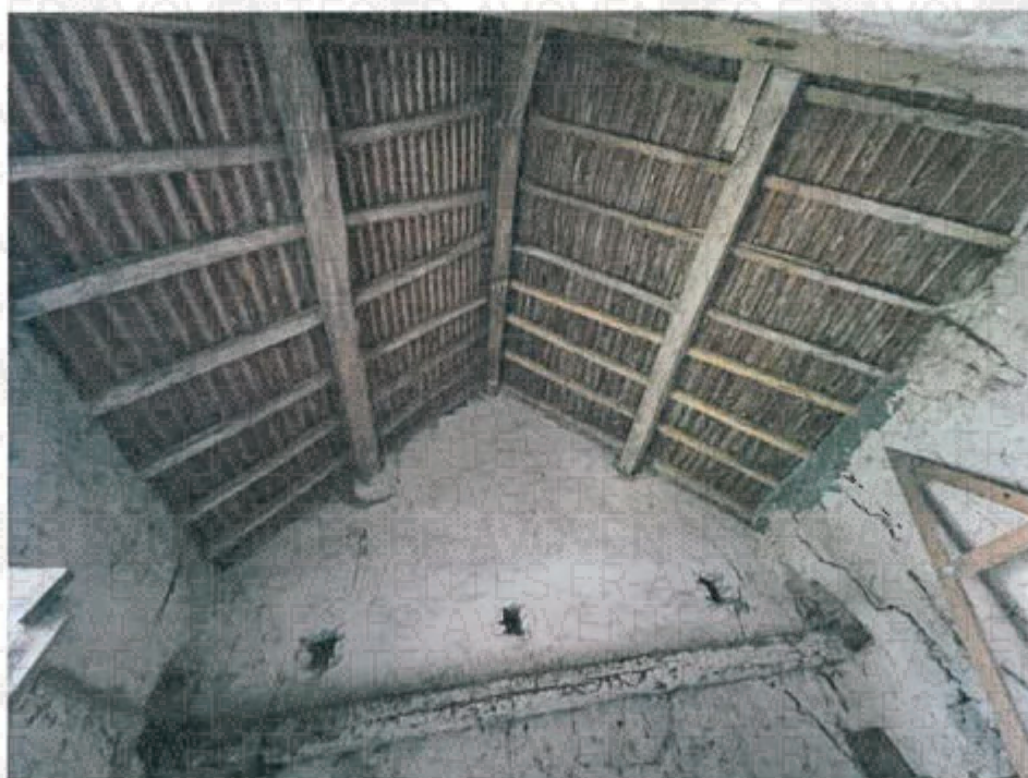
Plafond : belle charpente ancienne sous couverture en petites tuiles anciennes, moussues, zones ajourées au niveau de la ligne faîtière.
