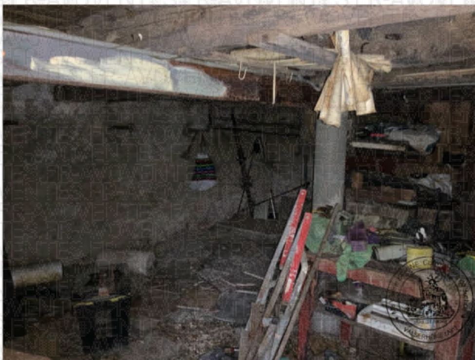
Cave (positionnée sous la cuisine) avec point d'eau.
