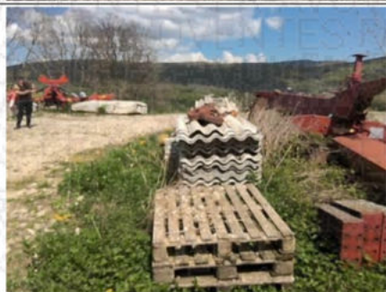
Photo n° PhA002 Localisation : Fosde a Isier 3 Ouvrage : 1 - Couvertures, Toitures, Terrasses et étanchéités - Plaques ondulées et planes Partie d'ouvrage : Plaques en fibres-ciment (y compris plaques « sous tuiles ») Description : Plaques en fibres-ciment au sol Localisation sur croquis : M002
