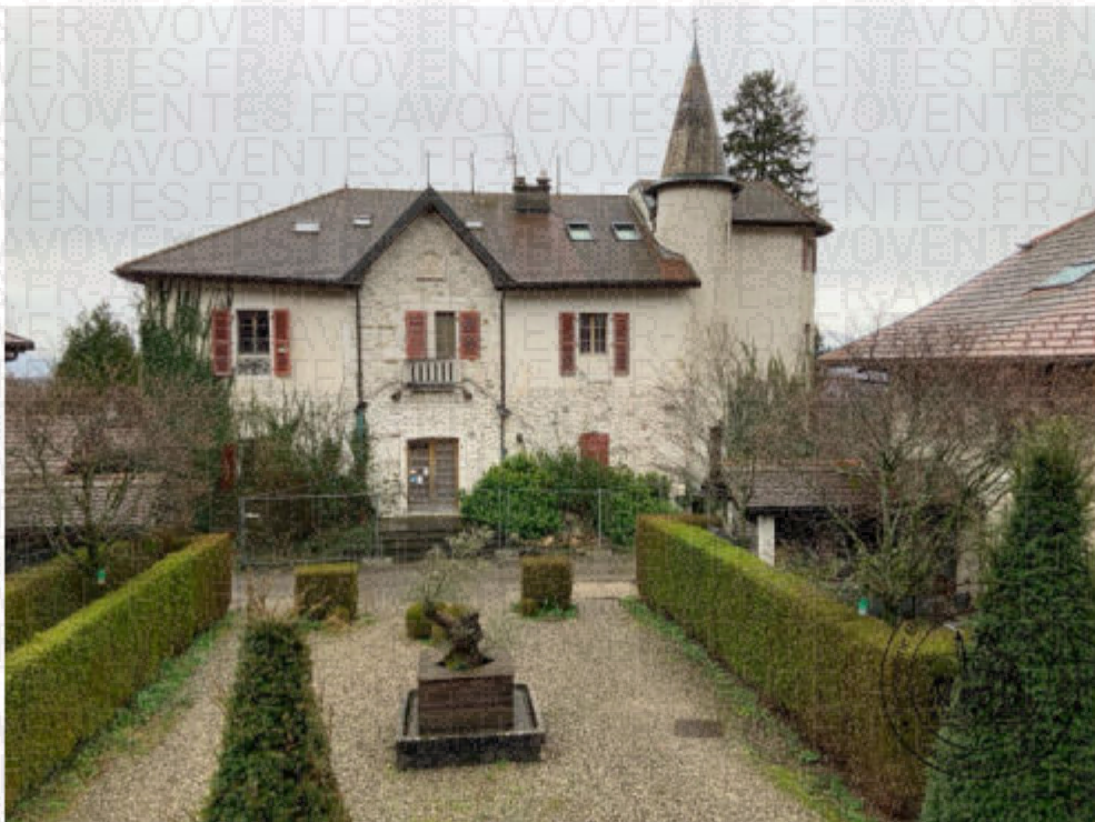
Cour séparant les deux bâtiments.
