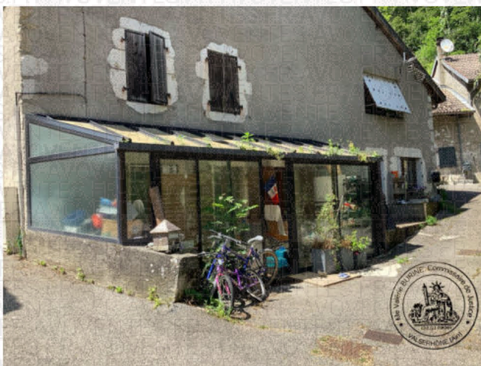
Véranda de 11,17 m 2
