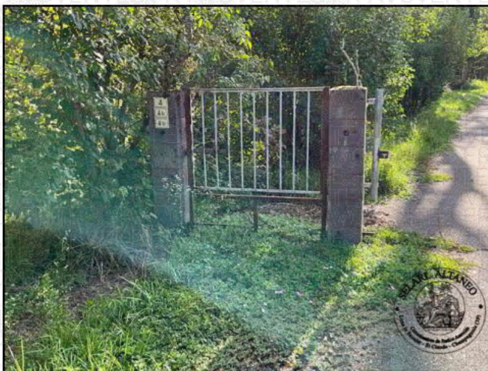
Photographie n°12. Portillon à l'entrée de la propriété
