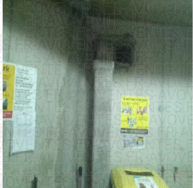
sous sol / local poubelles / gaine ventilation amiante ciment / 1505219414384NSA.png :
