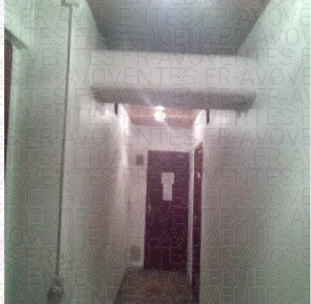
sous sol / dégagement ascenseur / gaine ventilation amiante ciment / 1505219272618NSA.png :
