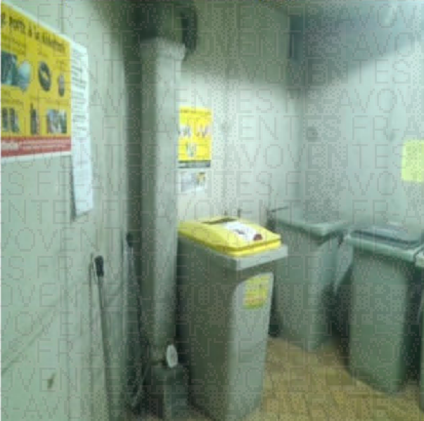
sous sol / local poubelles / gaine ventilation amiante ciment / 1505219414384NSA.png :
