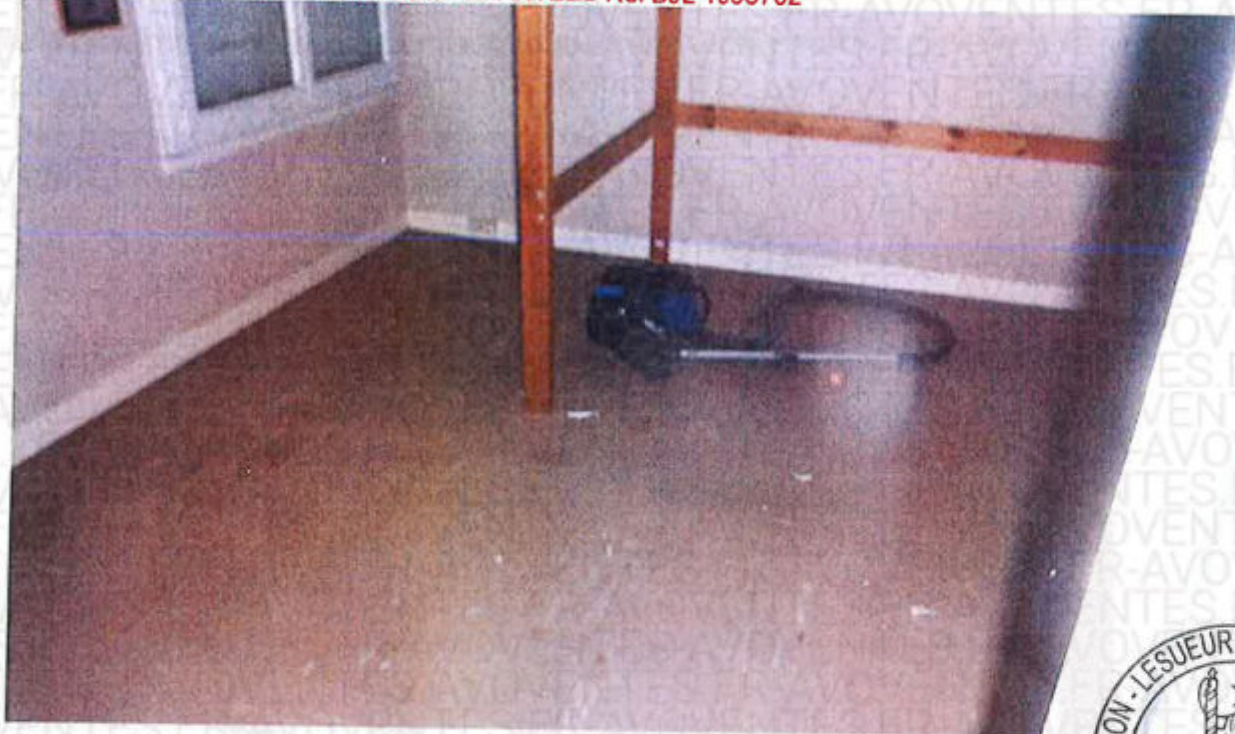
Prélèvement 2 : dalles de sol grises AMIANTEES Ref B JL 1063703
