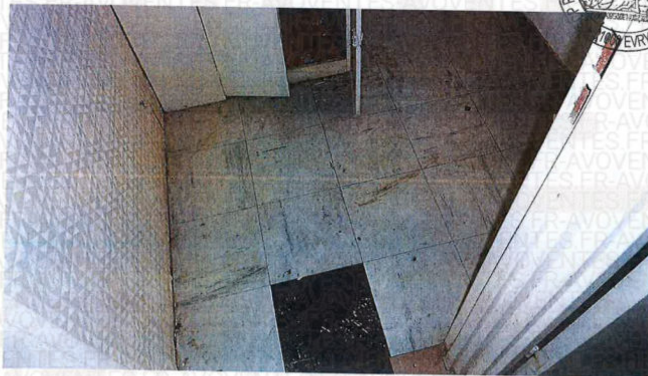
Prélèvement 2 : dalles de sol grises AMIANTEES Ref B JL 1063703
