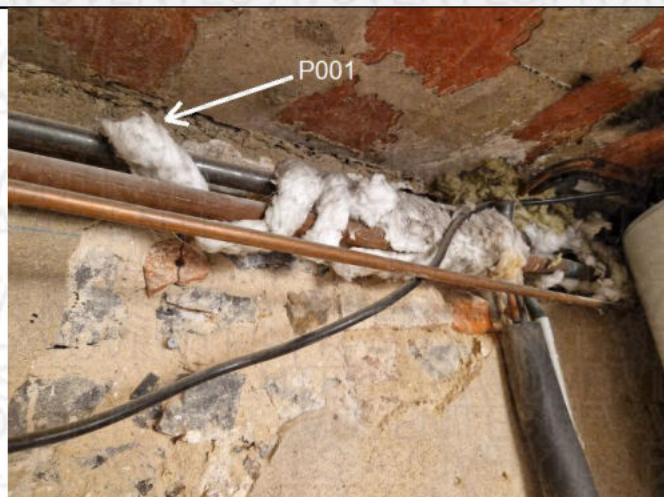
P001. Garage 1 - Conduit - Calorifuge (Blanc fibreux) – Résultat négatif
