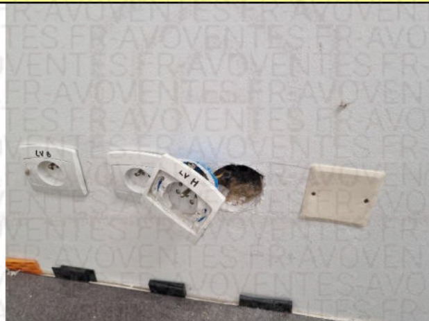
Mauvaise fixation du socle de prise
