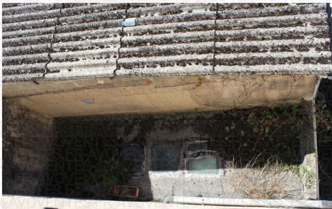
92 toiture au-dessus de l'ancienne salle d'eau du bar
