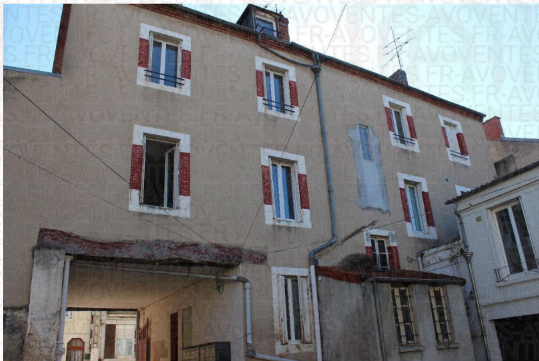
4 vue depuis la cour
