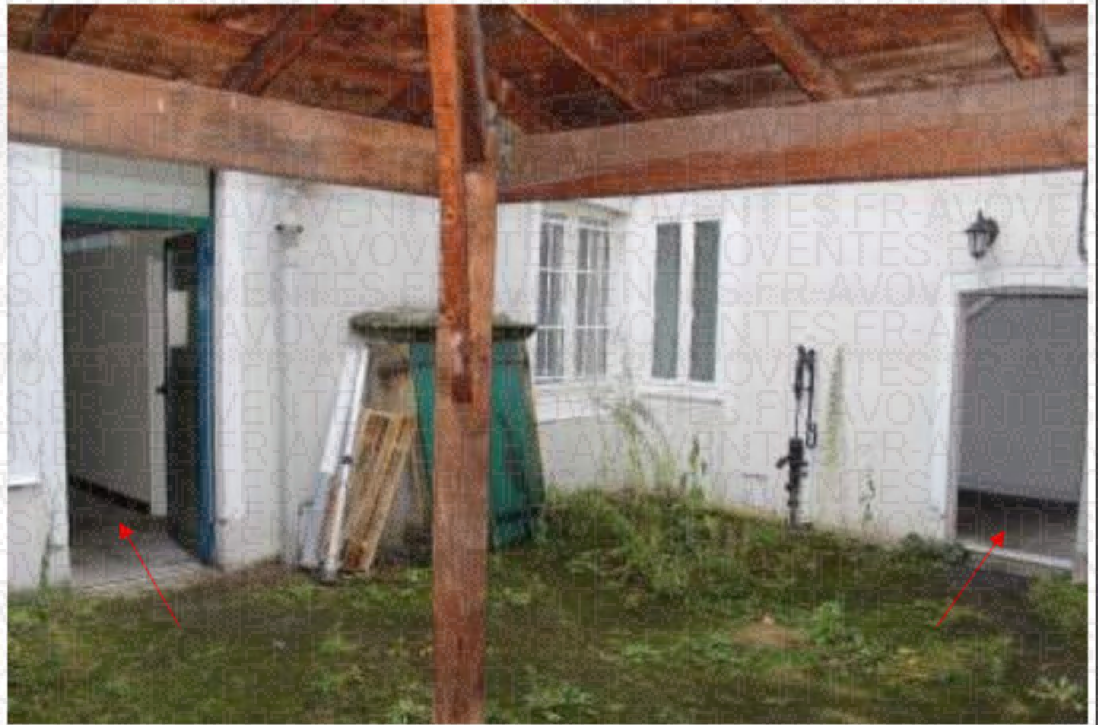
96-accès rue Montgolfier et bâtiment central
