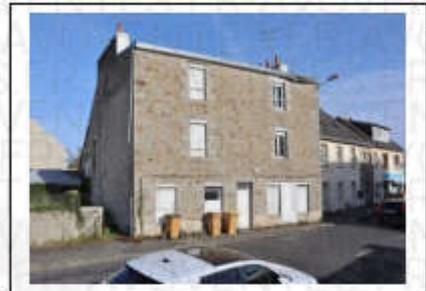
Un immeuble construit en pierres de pays, toit plat (apparemment en zinc) pour moitié et toiture à un pan en ardoises artificielles, composé d'un rez-de-chaussée, d'un premier étage et d'un deuxième étage.
