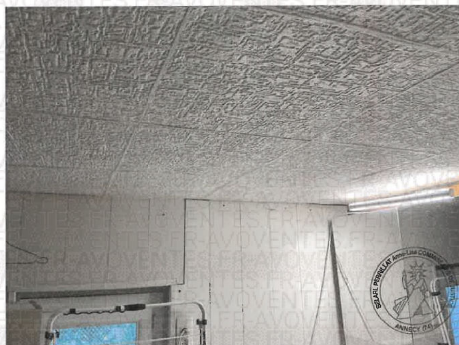
Le plafond est pourvu de dalles de fauxplafond.
