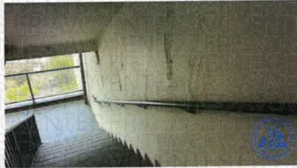
Dans les couloirs et escaliers, d'importants signes d'infiltration d'eau sont visibles aux murs et aux plafonds, et ce, à tous les étages.
