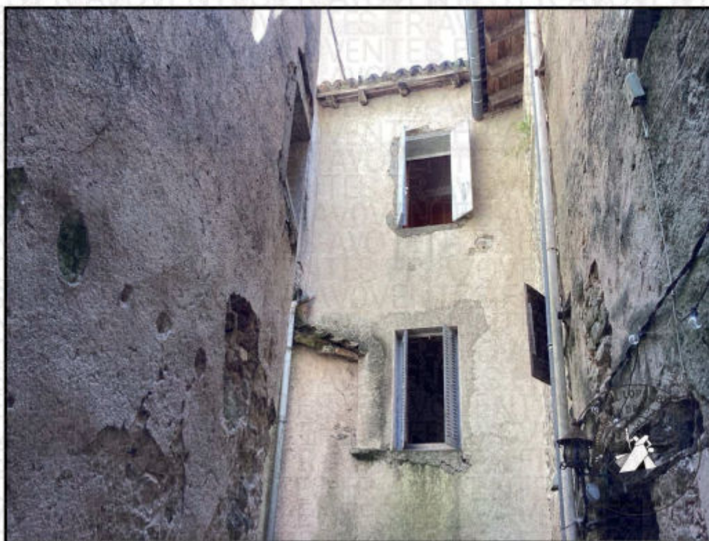
La façade OUEST de l'immeuble est crépée, largement écroulée en soubassement faisant apparaître les pierres apparentes.
