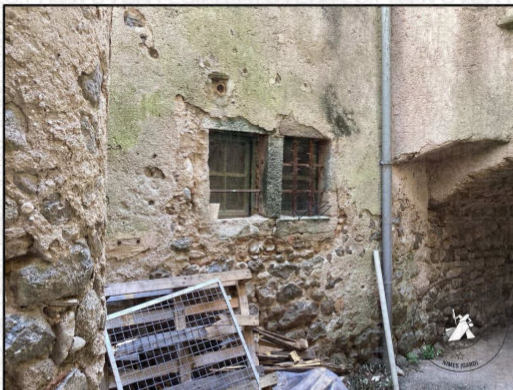
La façade OUEST de l'immeuble est crépée, largement écroulée en soubassement faisant apparaître les pierres apparentes.
