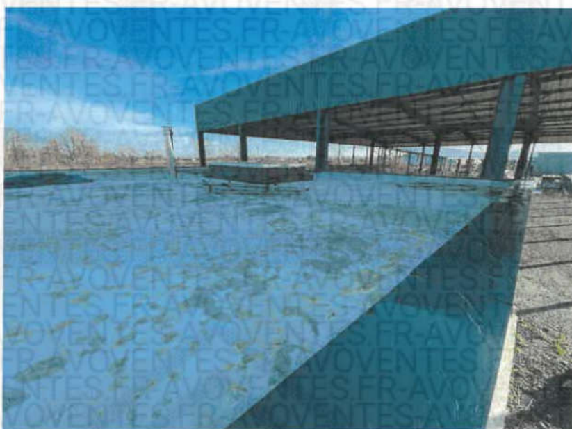
Photo n°30 : vue de la toiture du bâtiment administratif.
