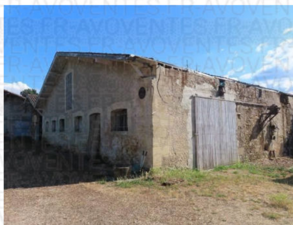
Ancien atelier : Sol chape béton cassée. Murs pierres.
