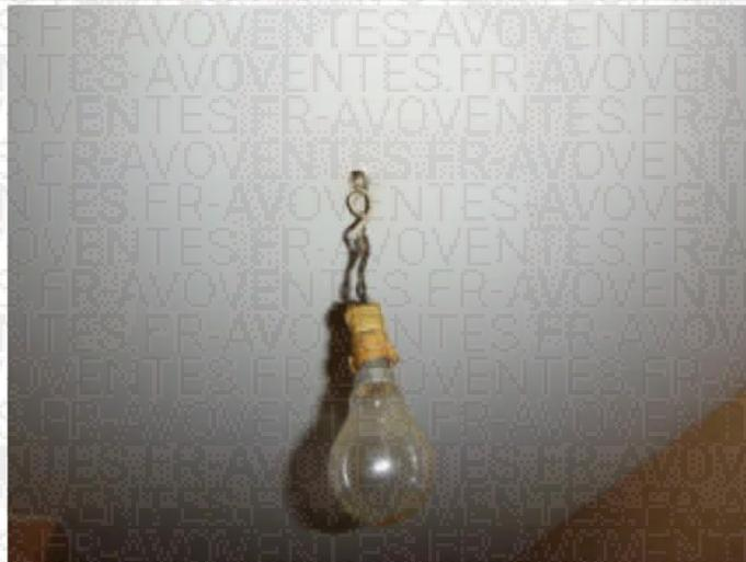
**Description :** Au moins un CONDUCTEUR isolé n'est pas placé sur toute sa longueur dans un conduit, une goulotte, une plinthe ou une huisserie, en matière isolante ou métallique, jusqu'à sa pénétration dans le MATERIEL ELECTRIQUE qu'il alimente.
