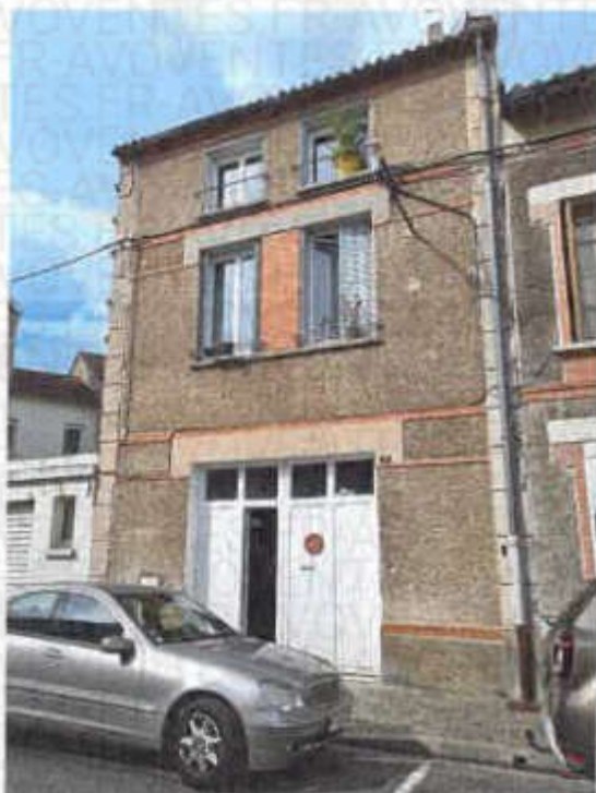
Immeuble 9 rue de l'inondation
