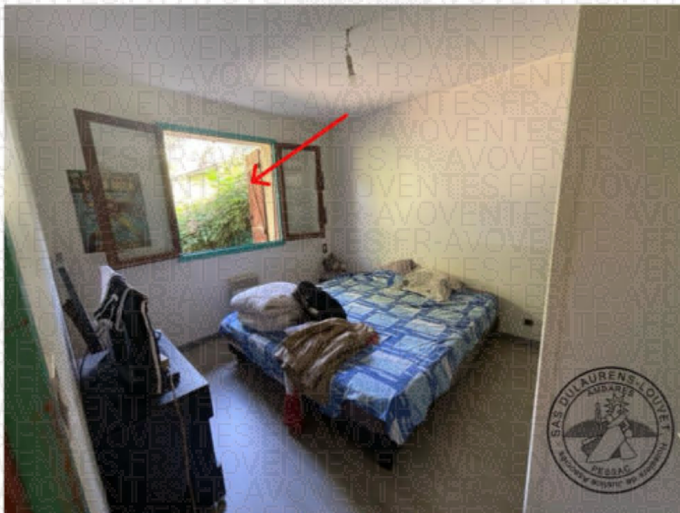
Fenêtre sur façade
