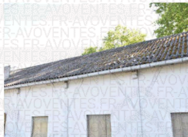
Couverture en plaques ondulées fibrociment, présence de mousse
