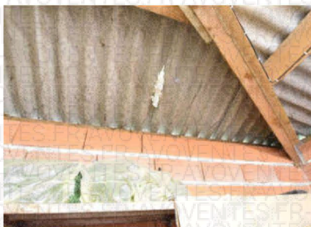
Dégradation locale des plaques ondulées fibrociment, porte métallique d'accès extérieur
