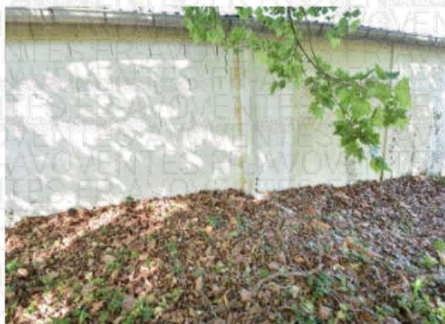
Fissuration en mur, colmatage
