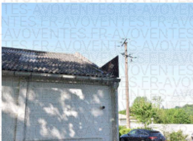
Couverture en plaques ondulées fibrociment, présence de mousse
