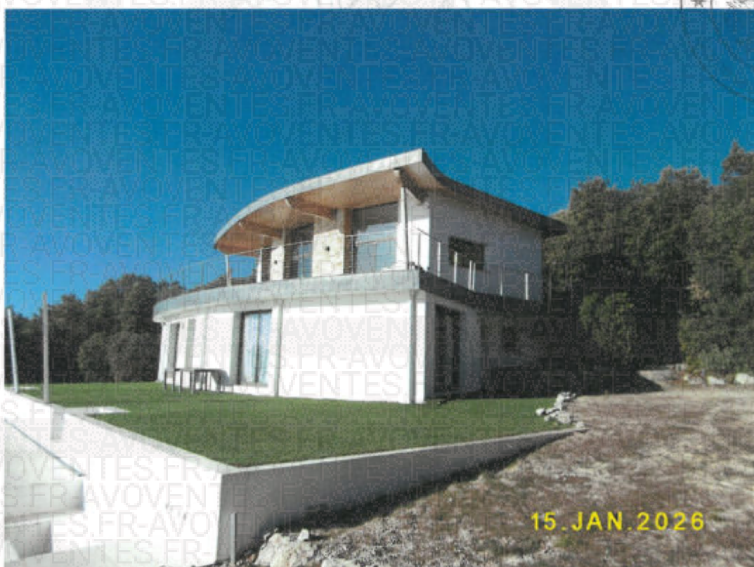
Photo 37 – Vue générale sur le bien immobilier
