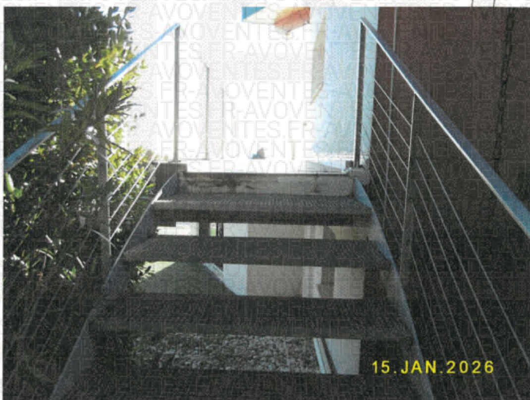
Photo 7 – Escalier d'accès à la terrasse
