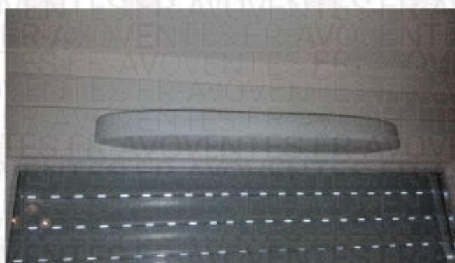
Volets roulant PVC avec entrée d'air hygrorèglable)
