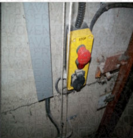
Le bouton d'arrêt en fond de cuvette.
