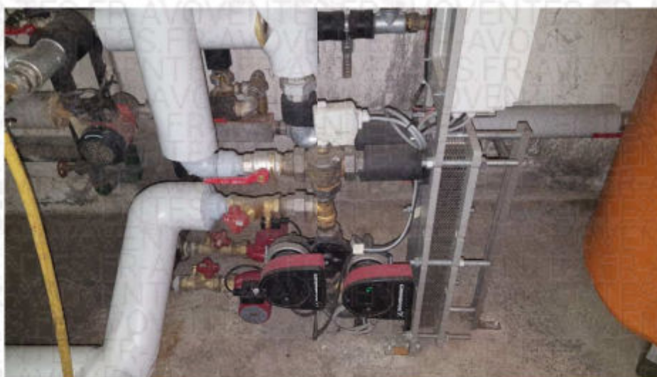
Circulateur à débit variable retour préparateur ECS
