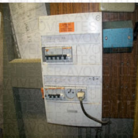
Le tableau d'arrivée de courant.
