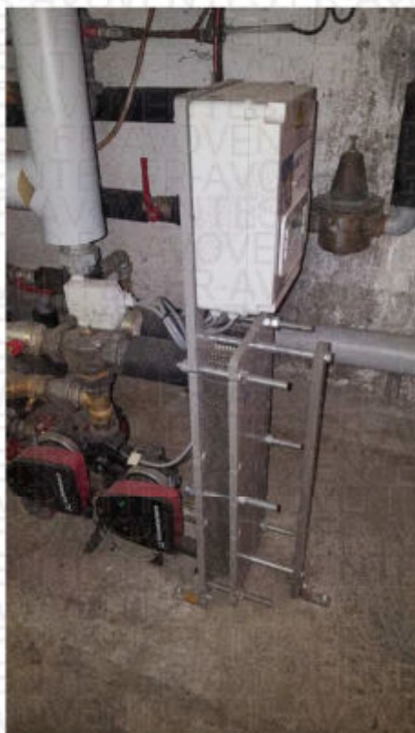
Préparateur ECS et Ballon de stockage de 500 litres
