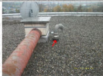
Photo n° PhA006 Localisation : 8ème étage - Toiture 46A - 46B - 46C Ouvrage : Conduits, canalisations et accessoires intérieurs et extérieurs - Conduits de fluides (air, eau, vapeur, fumée, autres fluides) Partie d'ouvrage : Conduit Description : Conduit de ventilation en fibro-ciment Localisation sur croquis : 006
