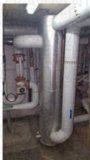
Circulateur à débit variable retour préparateur ECS
