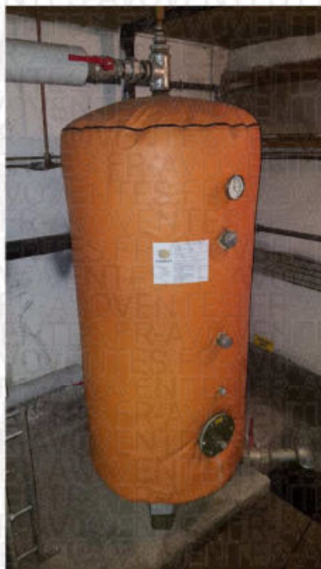
Préparateur ECS et Ballon de stockage de 500 litres
