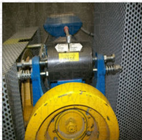
Les freins de la machine de traction.
