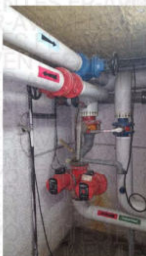
Circulateur à débit variable retour préparateur ECS
