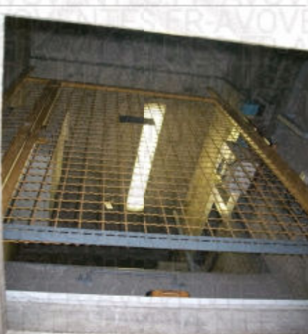
Accès à la machinerie.
