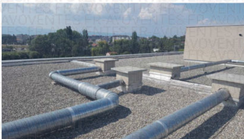
Etat de la toiture du bâtiment
