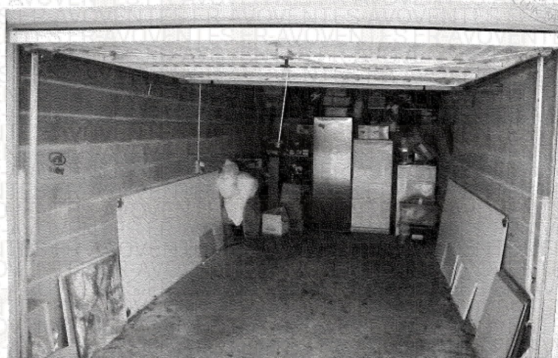
Sol : dalle béton et porte métallique basculante
