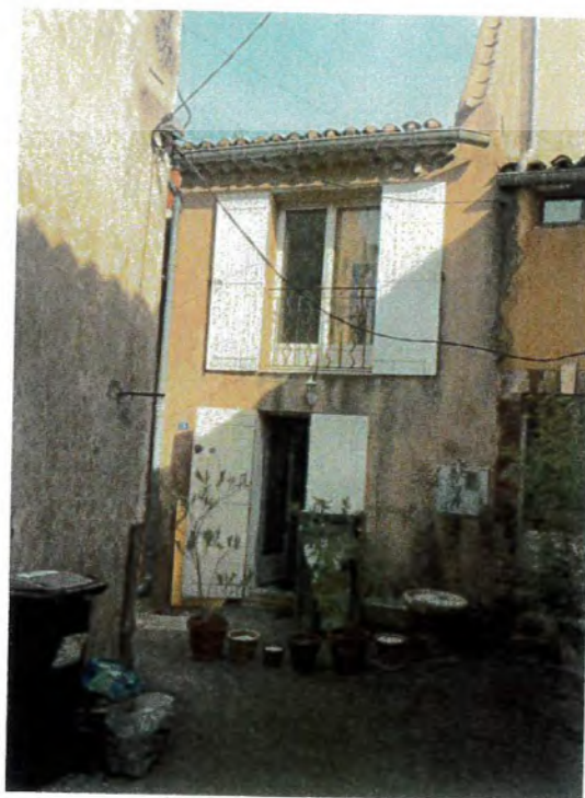
Façade Sud de la maison.
