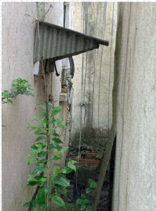
2.Fosse entre les deux constructions
