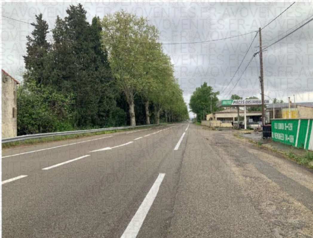
1. Route N7 au Nord en direction de la commune de LAPALUD
