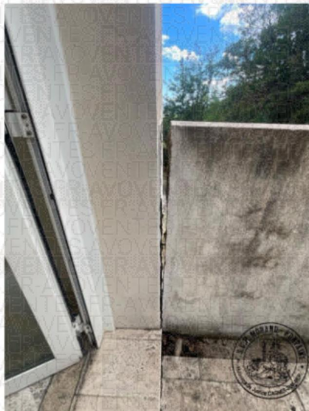
15. Décroché du mur bordant l'entrée de l'appartement sur l'exposition sud avec fers à béton visibles.
