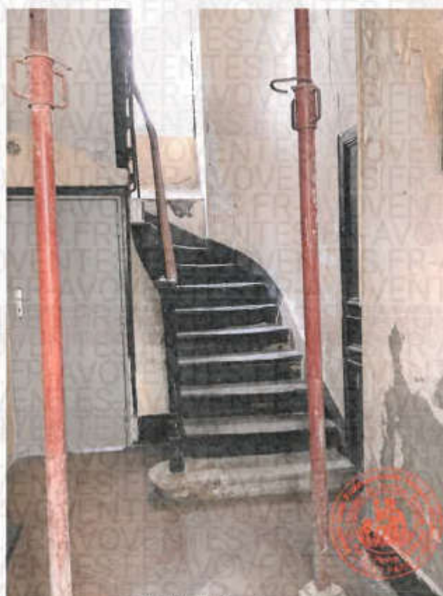
5. Hall du bâtiment sur cour
