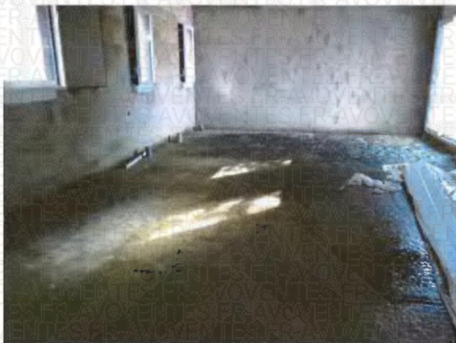
Les deux parties sont séparées entre elle par un hall d'entrée dont les murs sont montés en parpaing avec dalle béton au sol. La porte d'entrée n'est pas posée.
