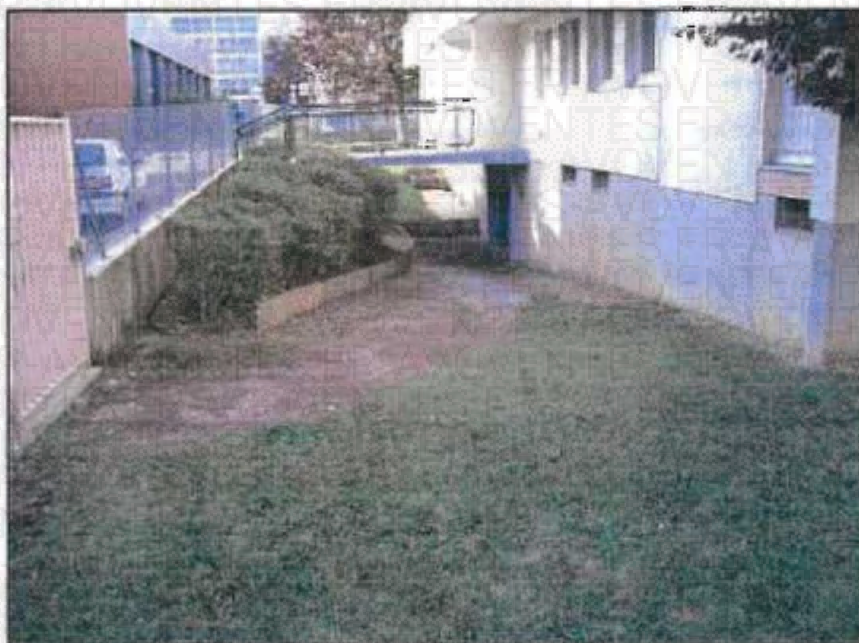
Figure 2: Point bas en zone d'aléa faible de ruissellement.
