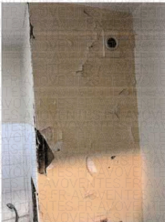
Murs : Revêtement peinture, les murs sont détériorés avec des plaques de plâtre arrachées. Peinture écaillée.
