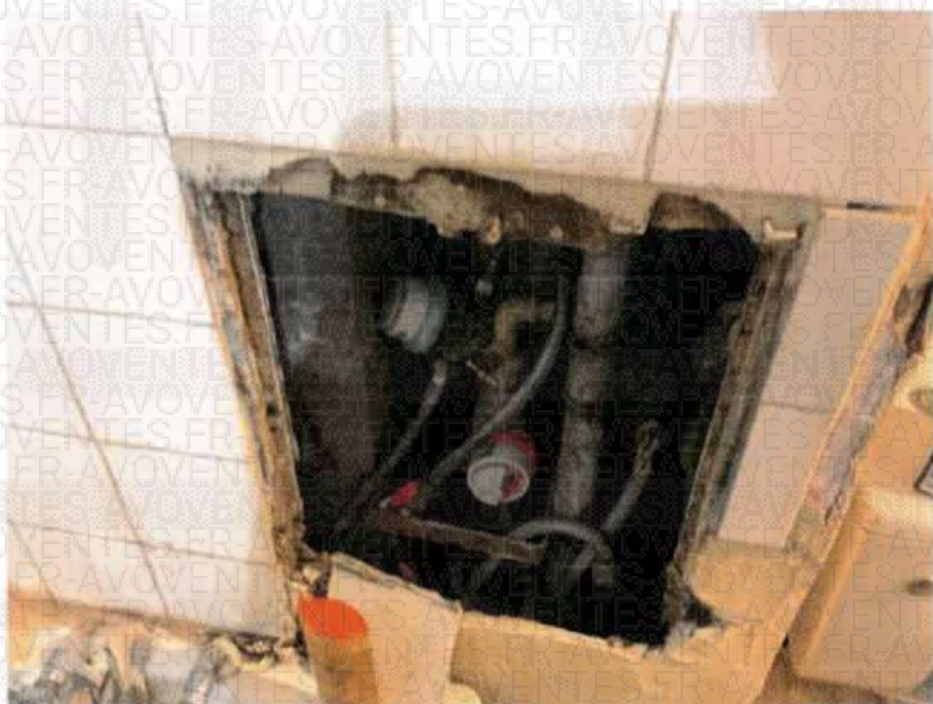
Il manque la trappe de visite sur le mur de droite là où se situent les compteurs d'eau.
