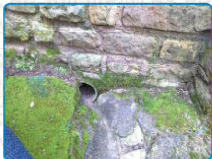
Décision opérateur n° 3 : Conduits de fluide Fibres-ciment (dans Maison principale n°1 Extérieur)
