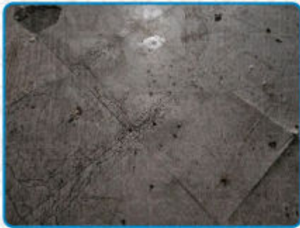
Prélèvement n° 1 : Sol Dalles de sol (dans Bâtiment Rez de chaussée Magasin)
