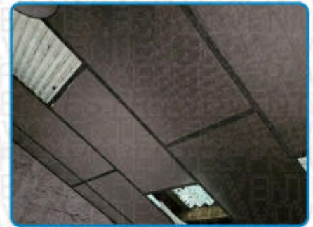
Prélèvement n° 3 : Faux plafond Plaques isolantes type laine de verre (dans Bâtiment 1er étage Mezzanine)
