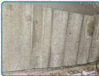
Décision opérateur n° 3 : Bardage Plaques fibres ciment (dans Bâtiment Extérieur Façades)
