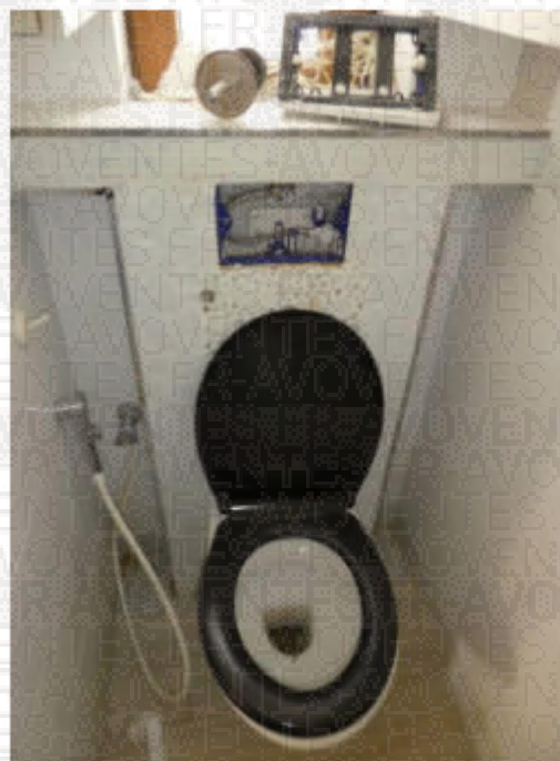
Un cabinet d'aisances suspendu avec réservoir dorsal encastré et douchette en partie gauche.
