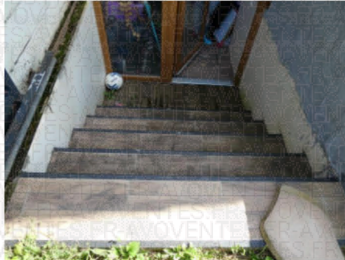
A droite, le fonds est délimité au moyen d'un grillage souple métallique fixé sur piquets métalliques.
