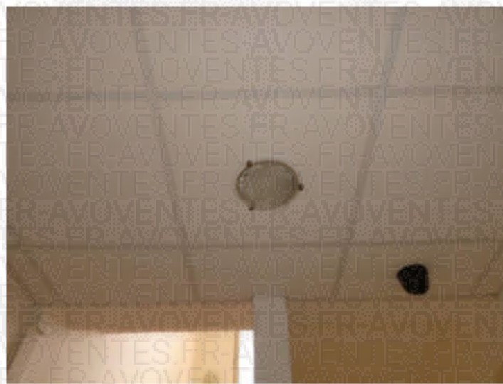
Au plafond, des dalles minérales posées sur armatures métalliques. Encastré, un point lumineux.
