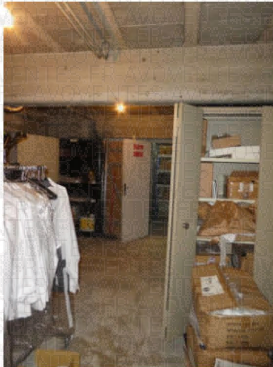
Dans cette pièce, l'accès au monte-charge précédemment décrit.
