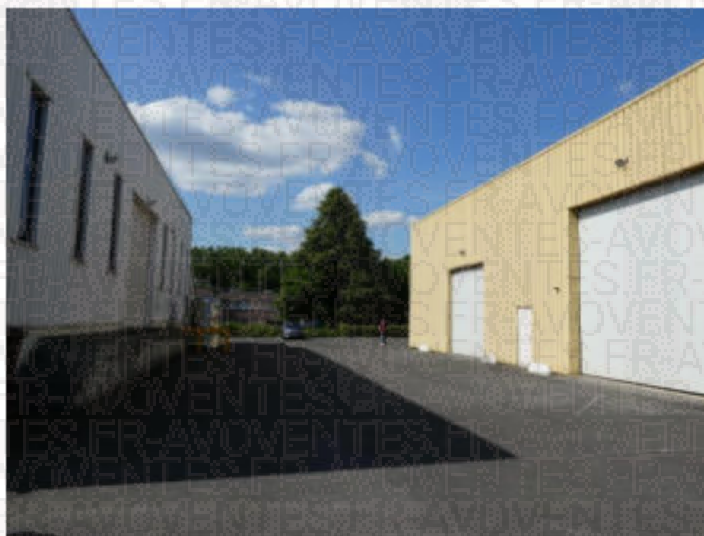
Au fond et en partie gauche, la parcelle est clôturée au moyen d'un grillage souple métallique fixé sur piquets métalliques.
