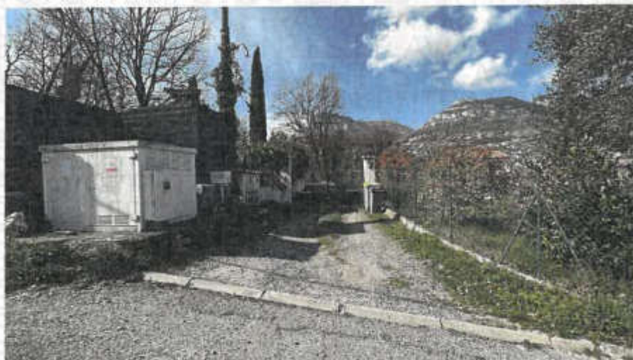
Au fond, un portail à deux battants métallique, ouverture motorisée.
