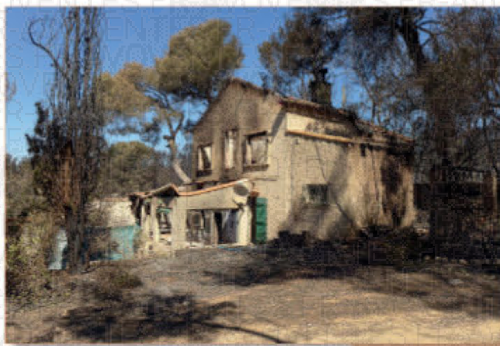
Maison non débroussaillée partiellement détruite par le passage d'un feu, Ragnac (13) -source : ONF
