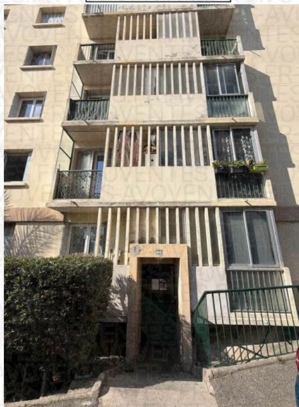
Façade du bâtiment D2
