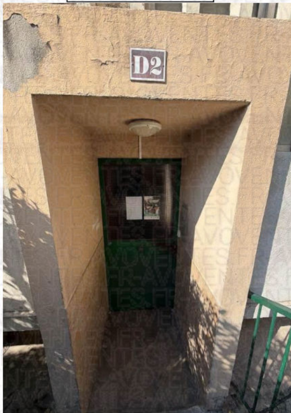
Entrée de l'immeuble
