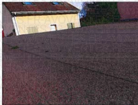
Couverture Shingle sur volume 3 : Absence d'amiante
