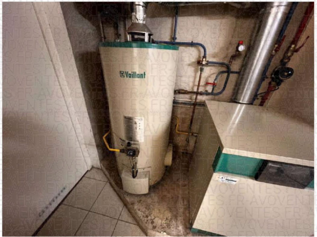
Chauffage : chaudière au gaz de ville de marque VAILLANT
