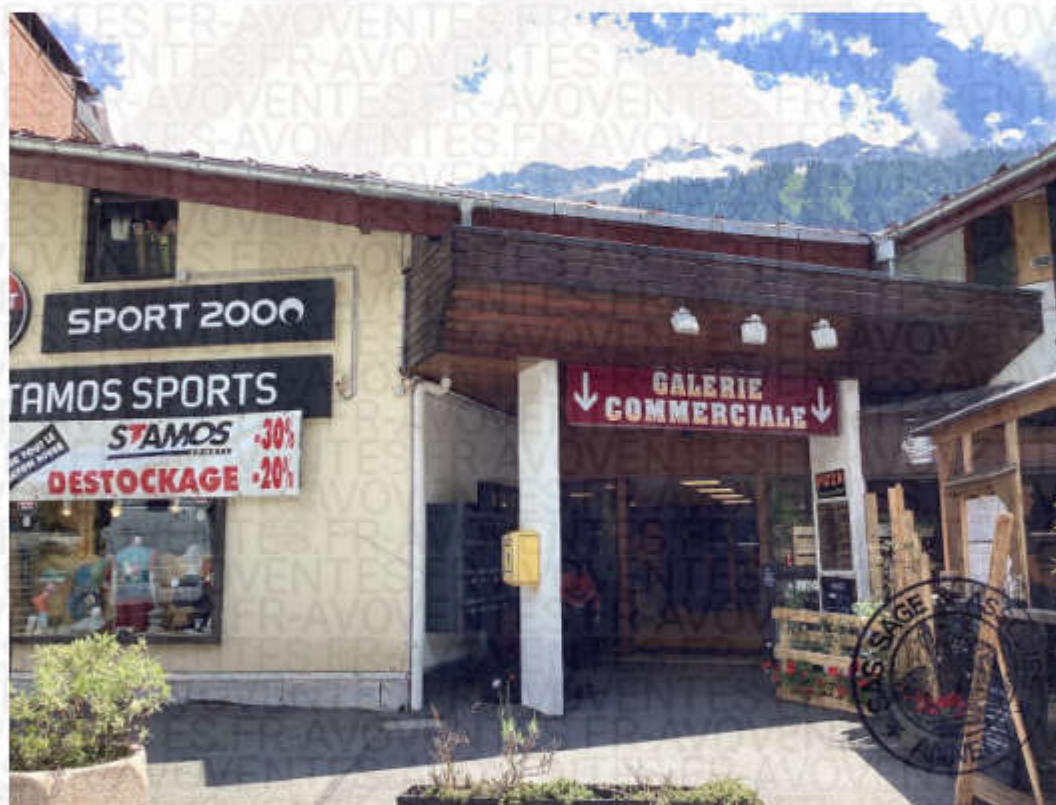
1. Accès galerie niveau 0
