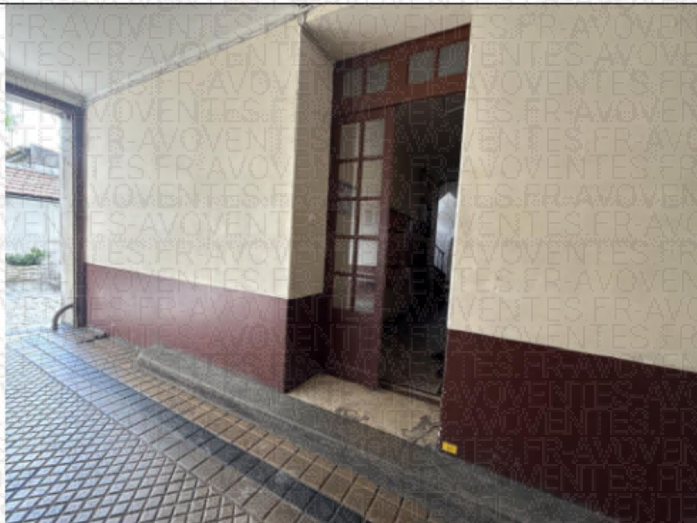
Cliché photographique de la façade arrière du bâtiment.
