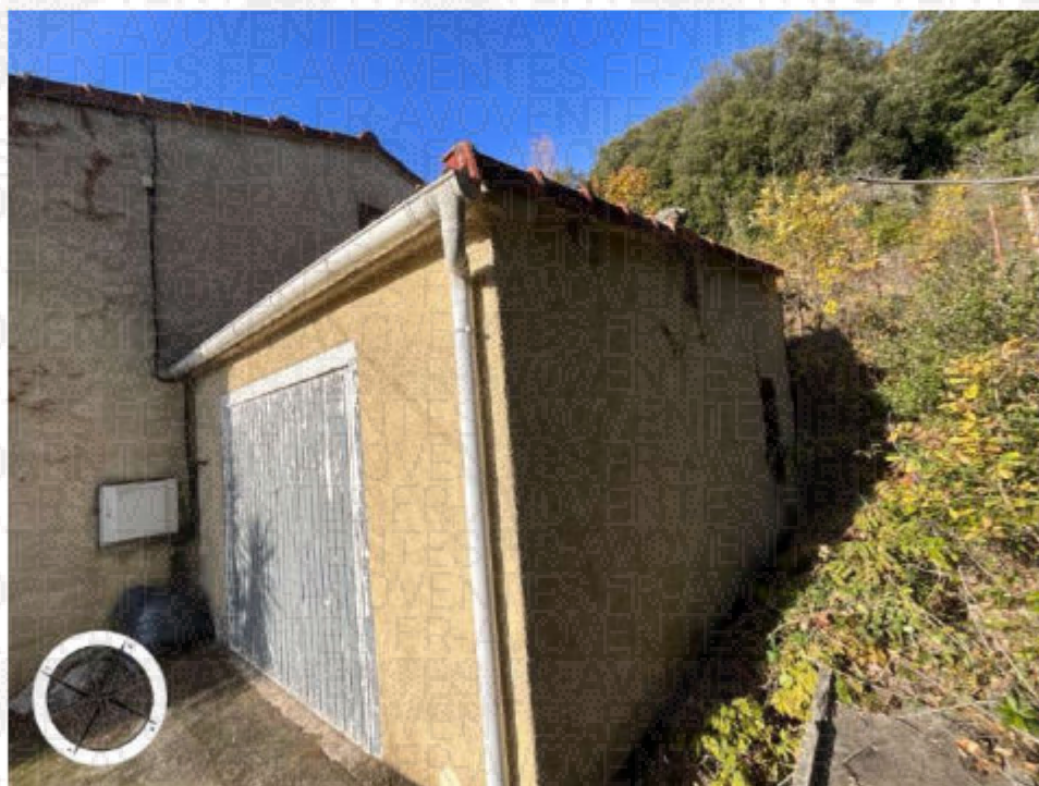
Photographie n°16: façade Nord
