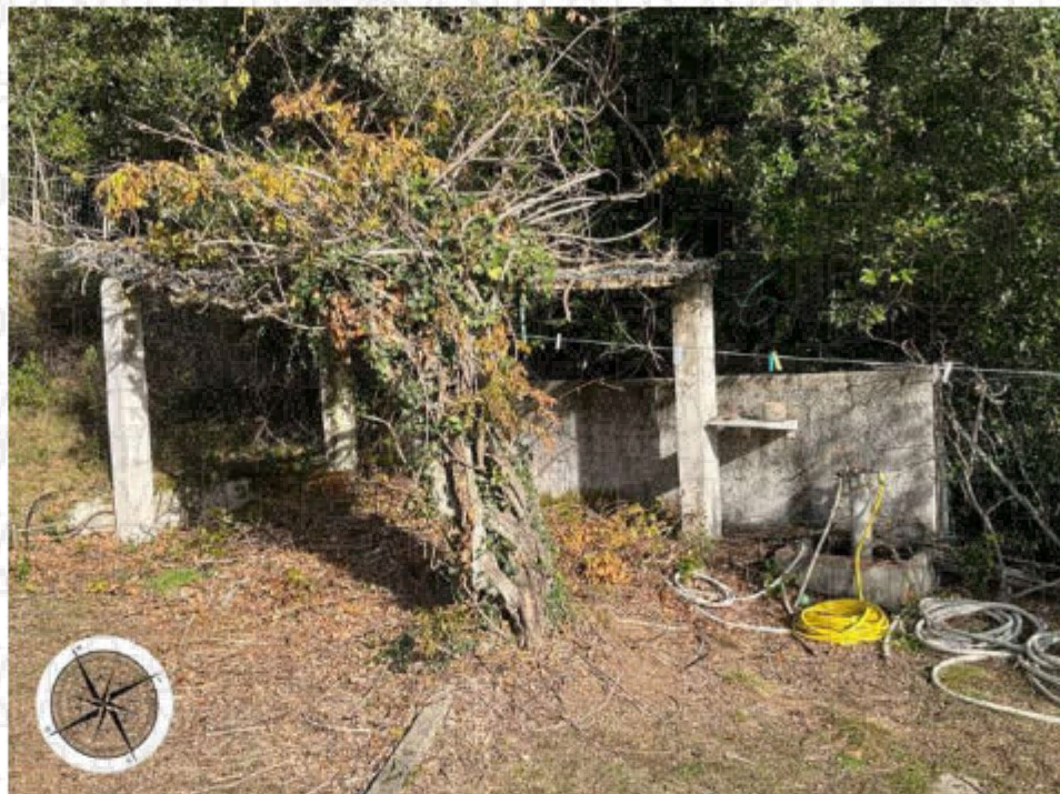
Photographie n°42. Structure légère extérieure ; avec point d'eau;
