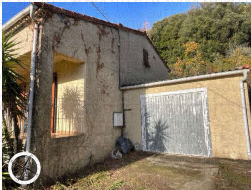
Photographie n°15: façade nord et garage
