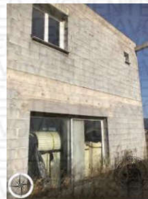
Photographie n°53. Façade Est
