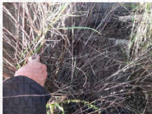
Photographie n°44. Regard de tout à l'égout placé dans l'angle sud Ouest du terrain derrière le placard de compteur d'eau en bordure de route de lotissement au Sud
