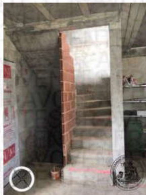
Photographie n°25. Montée d'escaliers vers le niveau R+1
