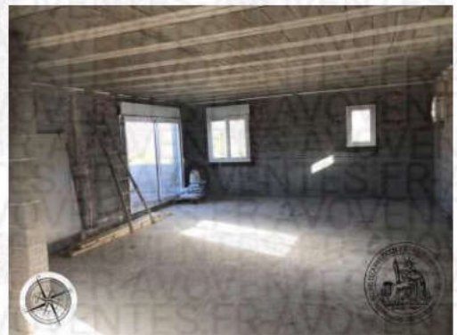
Photographie n°28. Espace chambres au R+1: non cloisonné: huisseries positionnées et placées; vue générale: du sol: dalle béton, murs: parpaings bruts, huisseries intérieures posées, plafond: hourdis en parpaings de ciment alvéolés
