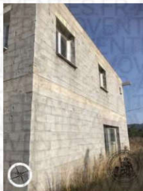
Photographie n°52. Façade Est
