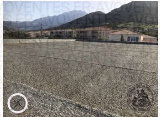
Photographie n°40. Partie toit béton, couvrant le R+1, plat, avec étanchéité constituée de calendrite et bardeaux lisses de bitume noir jointoyés et soudés au goudron chaud; Le tout en bon état apparent;
