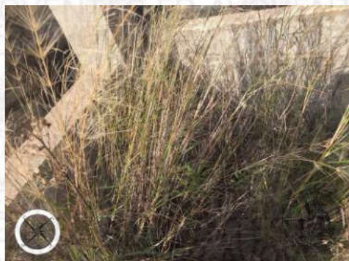
Photographie n°43. Regard de tout à l'égout placé dans l'angle sud Ouest du terrain derrière le placard de compteur d'eau en bordure de route de lotissement au Sud
