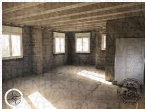
Photographie n°29. Espace chambres au R+1: non cloisonné: huisseries positionnées et placées; vue générale: du sol: dalle béton, murs: parpaings bruts, huisseries intérieures posées, plafond: hourdis en parpaings de ciment alvéolés GPS : Latitude=42.52722, Longitude=8.81114, Altitude=78.60 m, Angle:105.91° Précision verticale=10.00m, Précision horizontale=4.00m, Heure GMT=2024-11-26 09:59:31.
